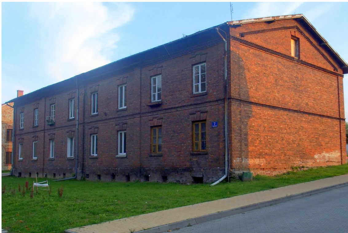
Widok budynku od północy
